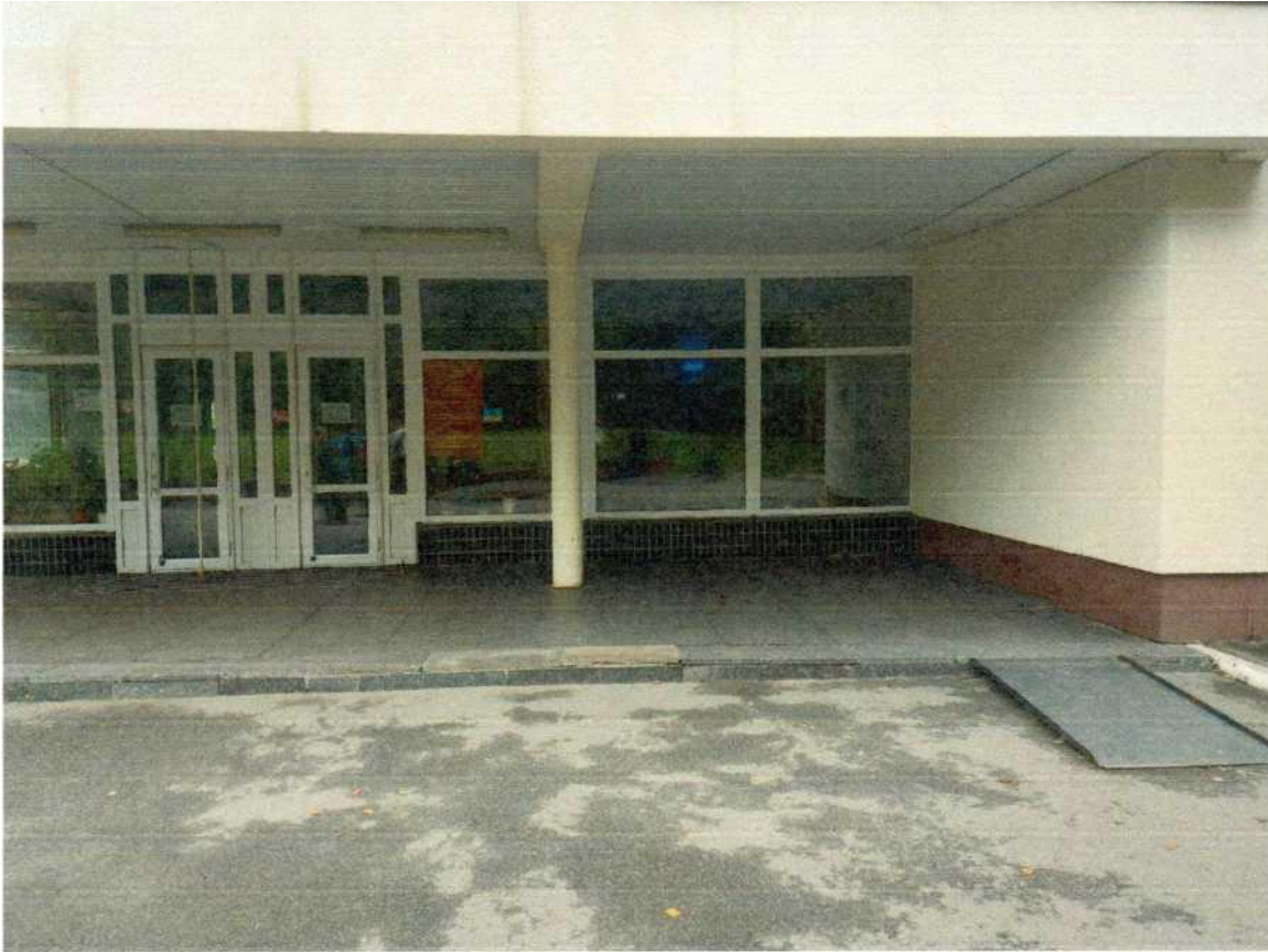
Фрагмент входу в приміщення прибудови №1
